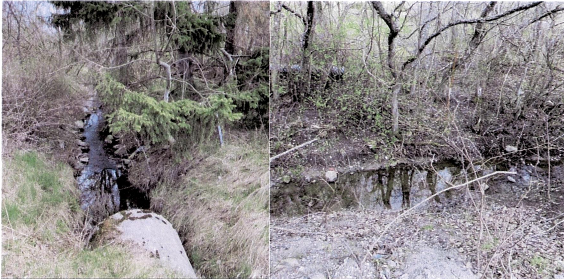
Figur 5. Befintligt dike vid Backebölsvägen vid korsning från Dalvägen
